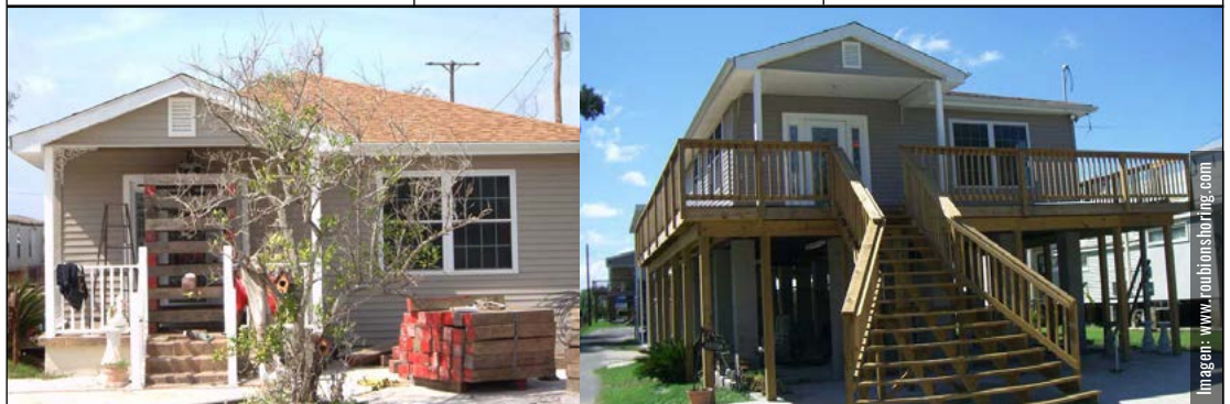
Antes y después de la elevación de una casa para sobrevivir inundaciones en Nueva Orleans, Louisiana.
